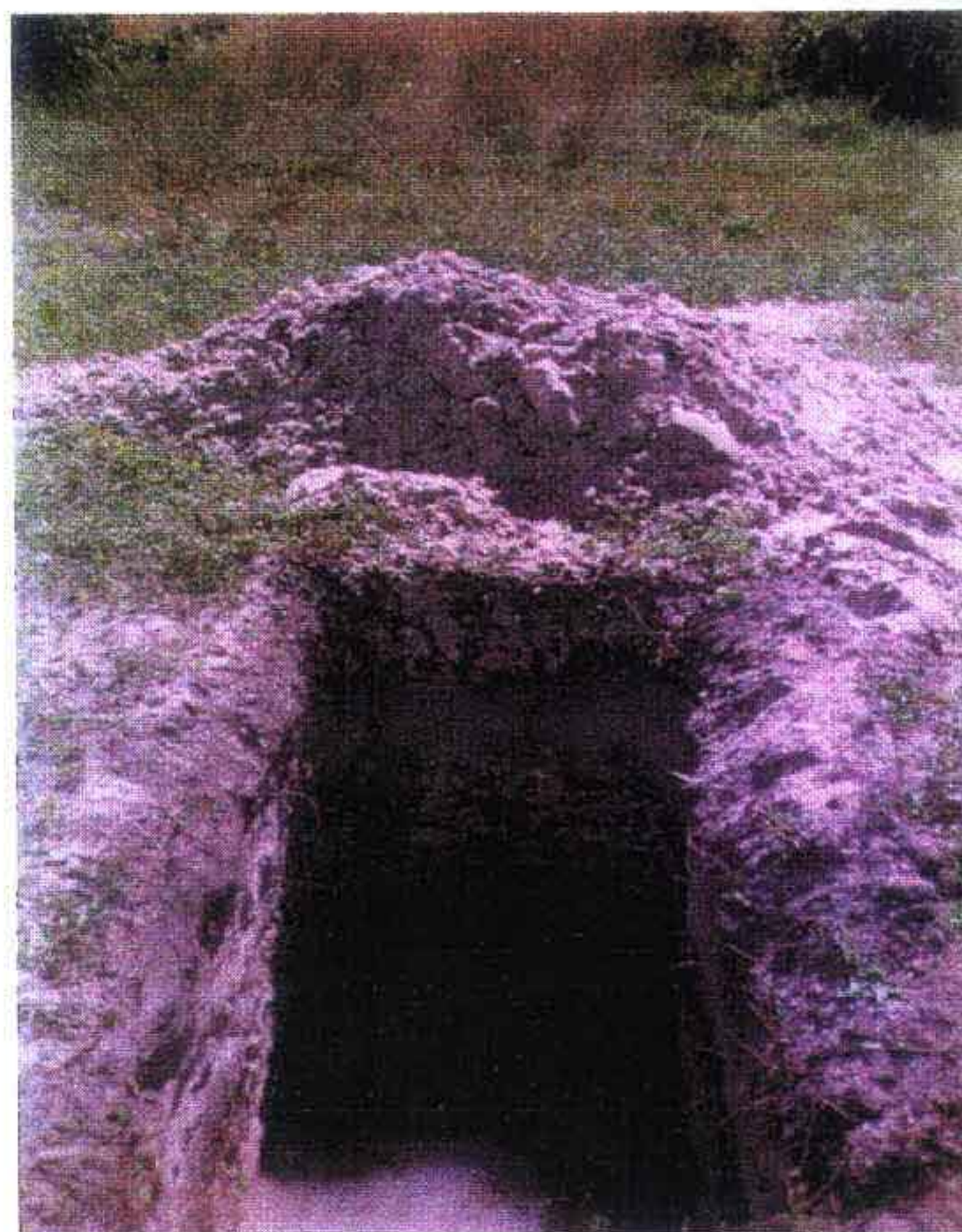
FOTO 4 - Furo no eixo da Barragem Malcozinhado
